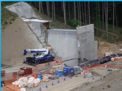
今回の工事は昨年度に行った工事の続きを行う工事です。現在は昨年度の工事で作り始めた砂防堰堤のコンクリートを引き続き打ち上げています。
