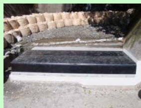
天端処理工（塩沢砂防堰堤）
