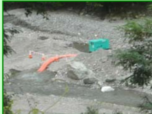
撮影箇所にて河を作るのにポンプで河道から水を送ります
