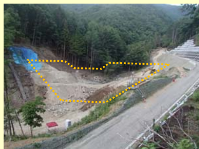
現在の工事の様子(下流から上流を望む)
