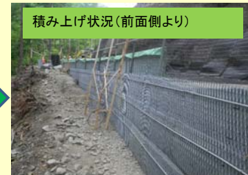
積み上げ状況(前面側より) 繰り返し作業することで、高くしていきます！！
