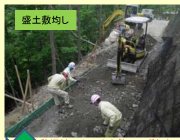
敷網材の上に土を敷いてずれないようにおさえます。
