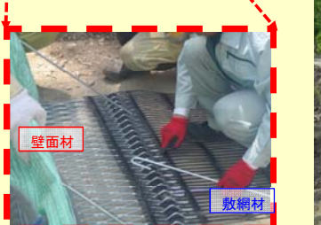
壁面材と敷網材を固定します。
