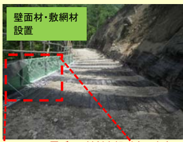
1層づつ、材料を組み立てます。
