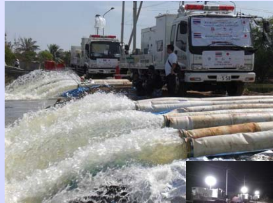
排水状況(夜間も実施→)
