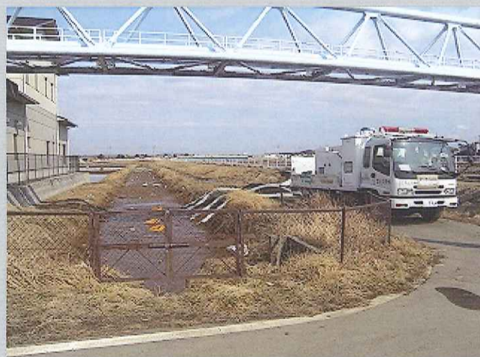
ポンプ車による排水作業の状況
