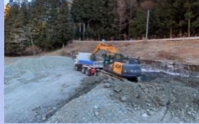
指示9：仮置き土運搬・埋立作業
