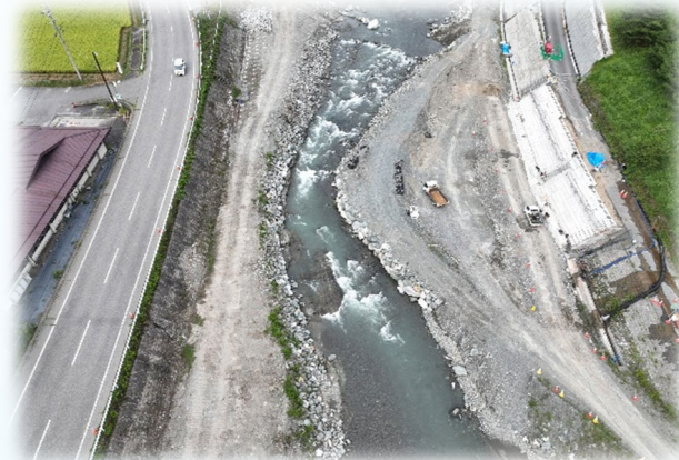
令和6年度 天竜川水系鹿塩川溪流保全工工事
