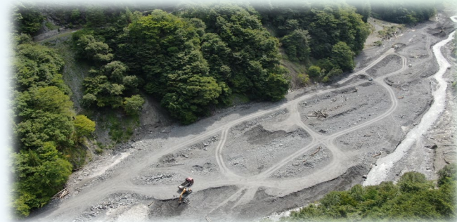
令和7年度 天竜川水系釜沢護岸工事
