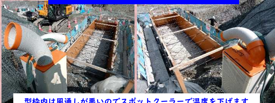
型枠内は風通しが悪いのでスポットクーラーで温度を下げます
