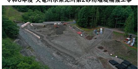
現在、コンクリート堰堤本体工、構造物撤去工の施工を行っています。(10.3%)6月末
