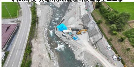
現在、帯工(左岸)の型枠組立・コンクリート打設作業を行っております。(12.0%)6月末
