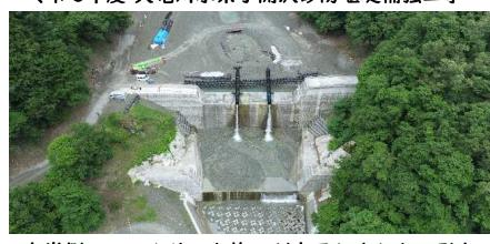
左岸側のコンクリート施工が完了しました。引き続き右岸側の施工になります。(18.0%)6月末
