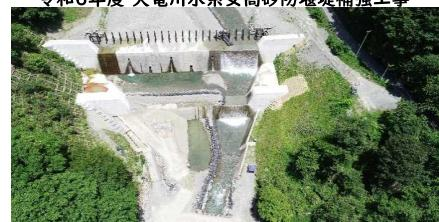
現在、右岸副堤下のカゴ枠及び側壁保護工の作業を行っております。7月より、構造物撤去工及び垂直壁工の土工に入っていきます。(5.2%)6月末
