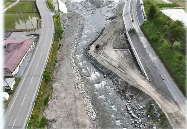
令和6年度 天竜川水系鹿塩川溪流保全工工事
