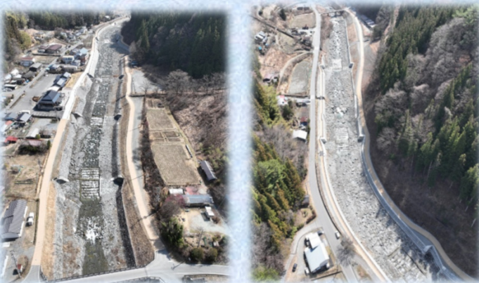
令和5年度天竜川水系塩川床固工群管理用道路工事
