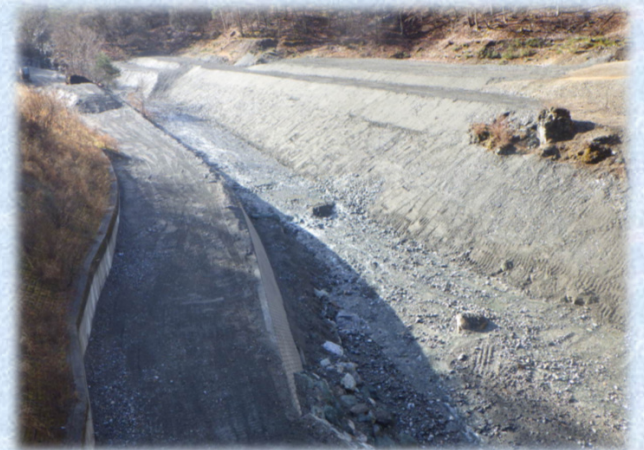
令和6年度天竜川水系小渋川砂防管内整備工事
