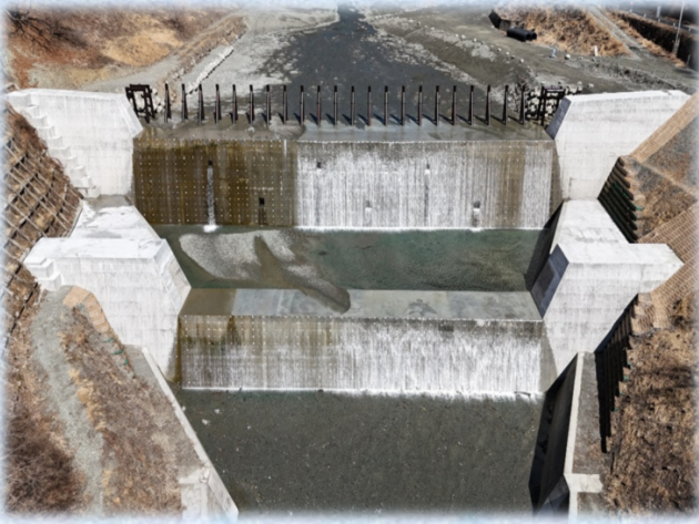
令和5年度 天竜川水系女高砂防堰堤前庭保護工補強工事
