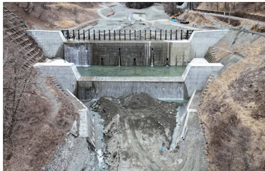
令和5年度 天竜川水系女高砂防堰堤前庭保護工補強工事
