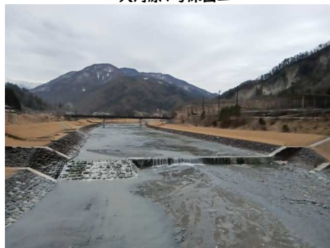
令和5年度 天竜川水系小渋川砂防管内施設補強工事 大河原1号床固工
