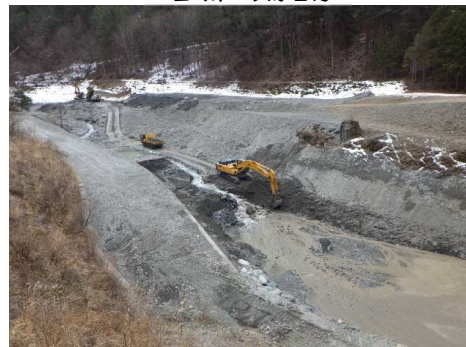
令和6年度 天竜川水系小渋川砂防管内整備工事 塩川第2砂防堰堤
