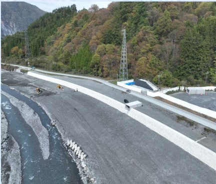
令和5年度 天竜川水系沢戸護岸工事
