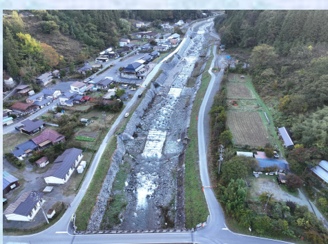
令和5年度天竜川水系塩川床固工群管理用道路工事
