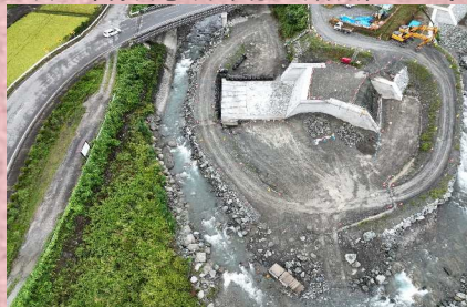
令和5年度 天竜川水系鹿塩川溪流保全工工事
