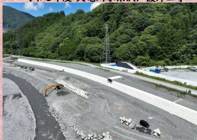
令和5年度 天竜川水系沢戸護岸工事
