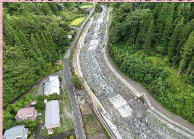
令和5年度天竜川水系塩川床固工群管理用道路工事
