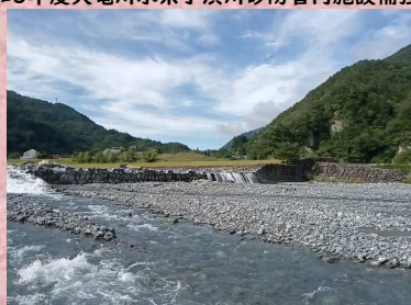
令和5年度天竜川水系小渋川砂防管内施設補強工事
