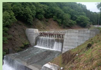
北川砂防堰堤
