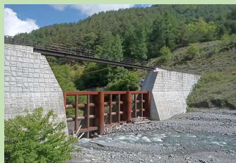
塩川第2砂防堰堤
