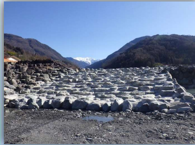
大河原4号床固斜路工
