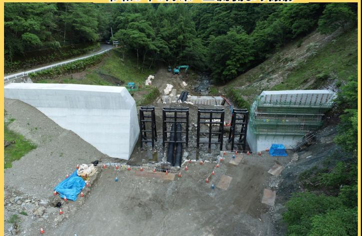
7月の予定として、本堰堤右岸側のコンクリート打設、副堰堤のワイヤーソー切断、構造物撤去作業へと進んでいきます。引き続き地元の皆様のご理解とご協力をお願いします。
