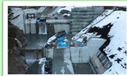
堰堤腹付コンクリートが完了し、鋼製スリット・水叩き・側壁工・根固工を施工しています。3月末まで工期が伸びました。引き続きご理解ご協力の程よろしくお願い致します。
