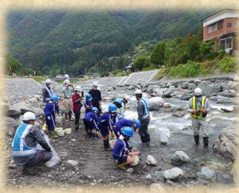
小渋川砂防工事 現場見学会
