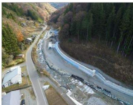
11月末で7号床固め工と護岸石積の一部と、井水用堤外水路が完成しました。現在、8号床固め工、残土処理の作業を行っています。工事期間も来年3月末まで延長になる予定です。引き続きご理解とご協力を宜しくお願い致します。
