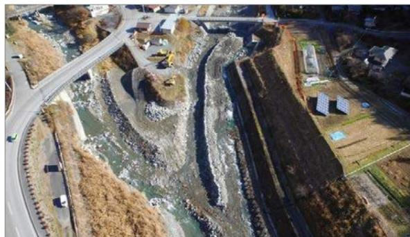
現在、仮締切工を施工しています。今後、左岸側の土砂の掘削に入る予定です。
