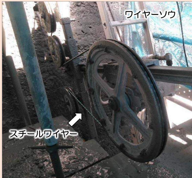
北川砂防堰堤補強工事では、既設のコンクリート砂防堰堤を切断するために、「ワイヤーソーイング工法」を実施しました。
