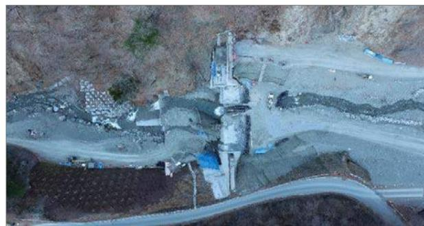
昨年に引き続き、根固めブロックの製作と腹付コンクリートの打設を行っています。引き続きご理解とご協力を宜しくお願いいたします。
