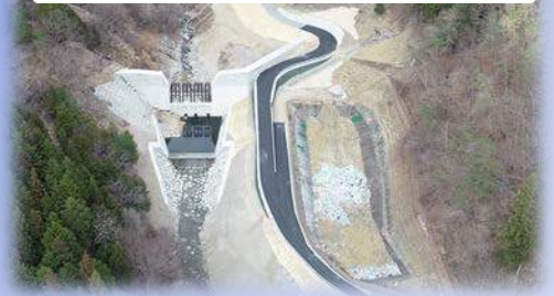
令和2年度 天竜川水系滝沢第2砂防堰堤工事
