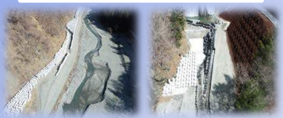
令和2年度 天竜川水系下伊那郡管内砂防施設補強工事
