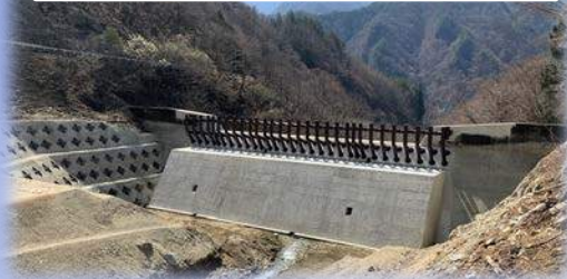
令和元年度 天竜川水系滝沢第1砂防堰堤改良工事
