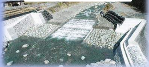
令和2年度 天竜川水系塩川床固工事
