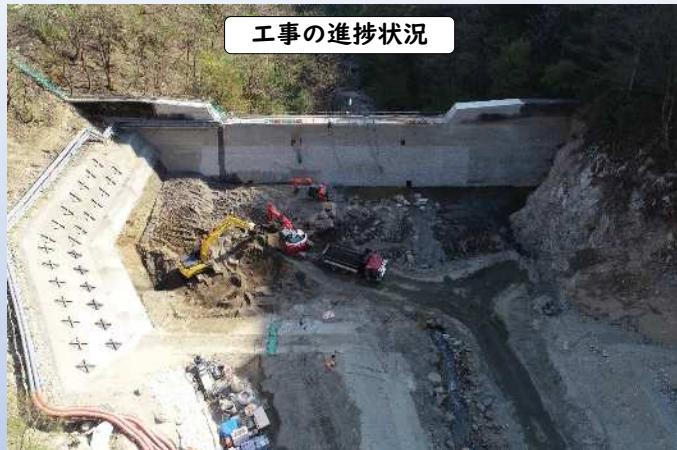
令和2年3月から堰堤上流側の床掘りと、法面の崩落を防止する受圧板アンカーエクスパンション工事を逆巻工法で施工しています。床掘りは深さ9m（計画13m）まで進んでいます。
