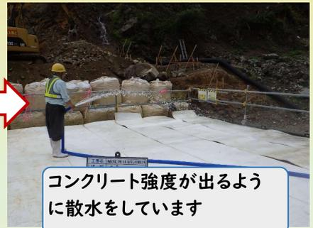
コンクリート強度が出るように散水をしています
