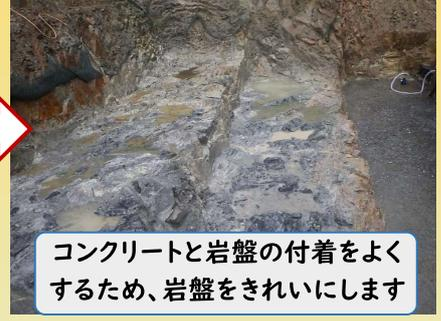
コンクリートと岩盤の付着をよくするため、岩盤をきれいにします
