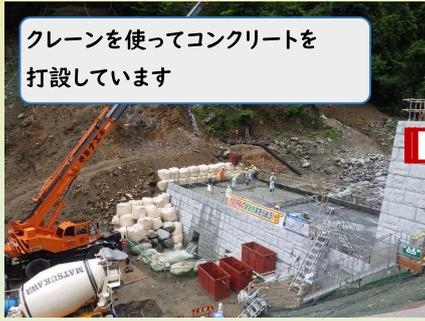
クレーンを使ってコンクリートを打設しています
