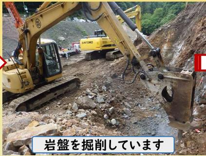
岩盤を掘削しています
