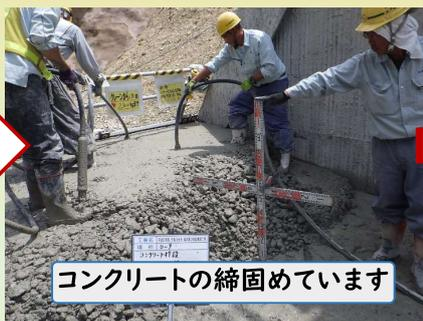
コンクリートの締固めています
