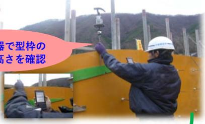
測量機器で型枠の位置と高さを確認
