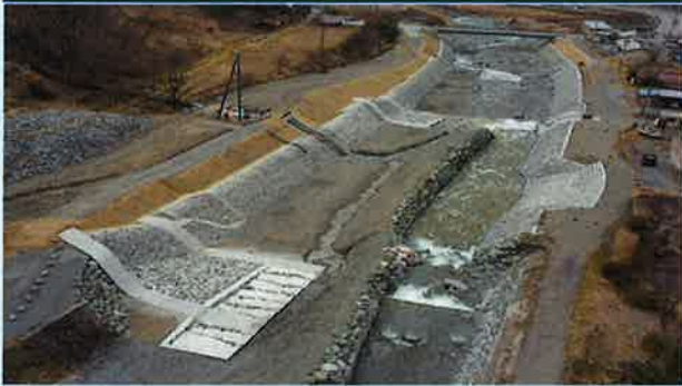
塩川床固工事 施工:株式会社 三六組
