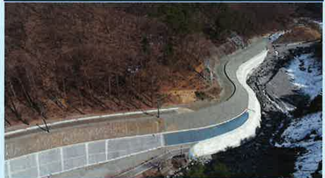
塩川第2道路付替工事 施工:長豊建設株式会社
