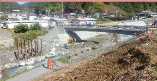
塩川橋が完成し、2号床固めを施工しています。(昭和コンクリート工業)
