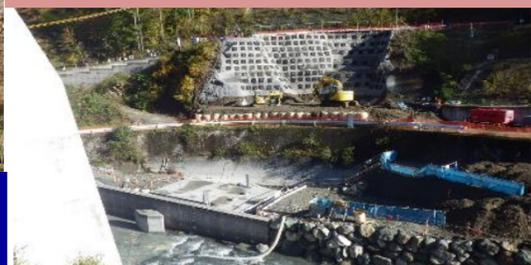
上流域の沢井地区で堰堤を作ります。現在堰堤の掘削作業中です。(神稲建設)
