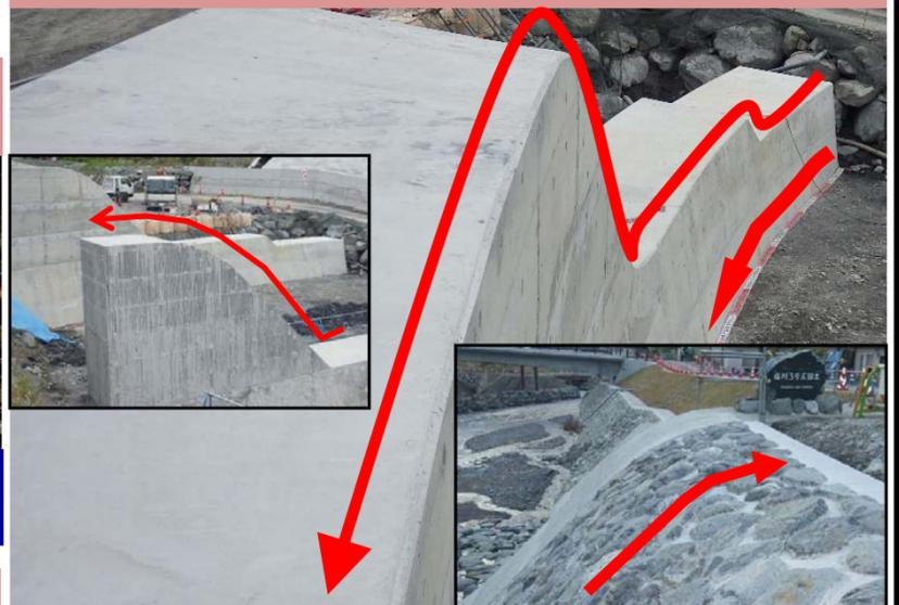
塩川の床固工群は大鹿村の景観に配慮し、構造物のいたるところに曲線構造が取り入れられています。また河川内にある自然石を加工し丈夫な護岸を作っています。曲線構造は直線の構造物に比べ製作に時間や手間がかかりますが、その分完成したときが楽しみで仕事をしております。現在、床固と護岸は完成しております。見学台も設置してありますので足を運んでいただけたら幸いです。今後ですが年内には塩の里前に親水階段と平らな石を使った高水敷張が完成します。土木技術者の誇りをかけて施工しております。完成時にはぜひこの床固工群を見に来てください。(大協建設)
