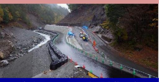
上流域の沢井地区で堰堤を施工するため村道付替え工事を行っています。現在、道路上部からの落石を防止する対策工事中です。(長豊建設)
