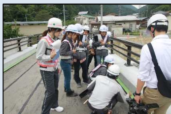
塩川橋PC上部工事現場
