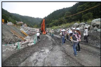
塩川床固工群工事現場
