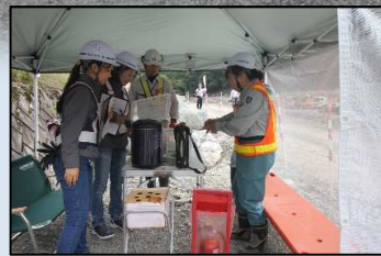
塩川第2砂防堰堤工事現場
