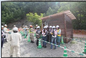
塩川第2砂防堰堤付替道路工事現場
