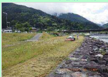
平成28年度 天竜川水系 小渋川砂防管内整備工事 施工者：シブキヤ建設株式会社
