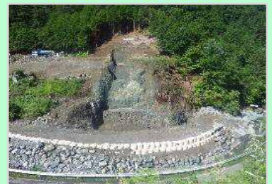
平成27年度 天竜川水系 塩川第2砂防堰堤工事 施工者：木下建設株式会社
