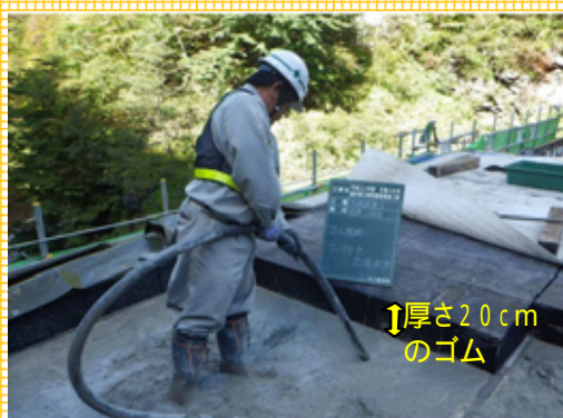
衝撃に強いゴム素材を用いて水通し部を保護しました
