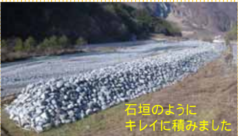
掘削した土砂をふるいわけし、今後の工事の資材として沢戸に仮置しました
