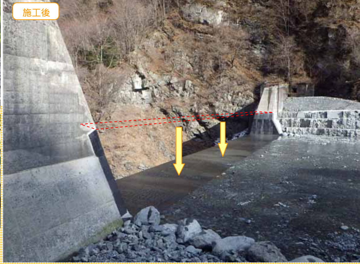
衝撃に強いゴム素材を用いて水通し部を保護しました
