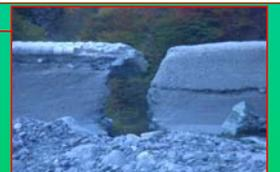
小渋川本川の上蔵と釜沢の間に位置し昭和31年に完成した榎村沢砂防堰堤は、度重なる出水から地域を守り、その結果大きな損傷を受けました。今回これを修復するための工事用道路を作ります
