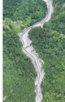
完成時 上空からの全景
