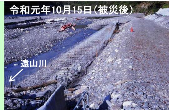
令和元年10月12日～13日にかけて、台風19号の降雨による出水で遠山川が増水し、仮締切が切れて現場に大量の土砂が流入堆積しました。現場を埋め尽くした大量の土砂を約1ヶ月かけて排除し、もとの工程に戻しました。
