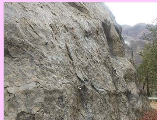
工事用道路の法面状況
