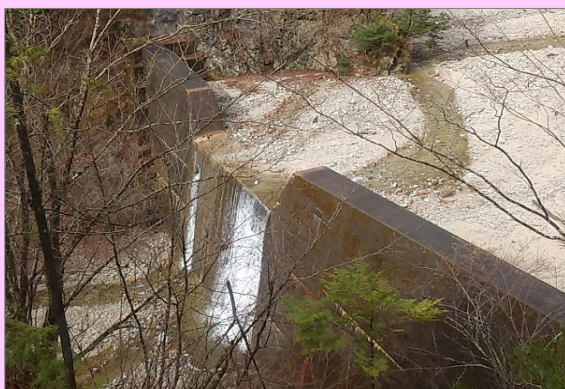
柳沢砂防堰堤（昭和63年（1988）完成）
