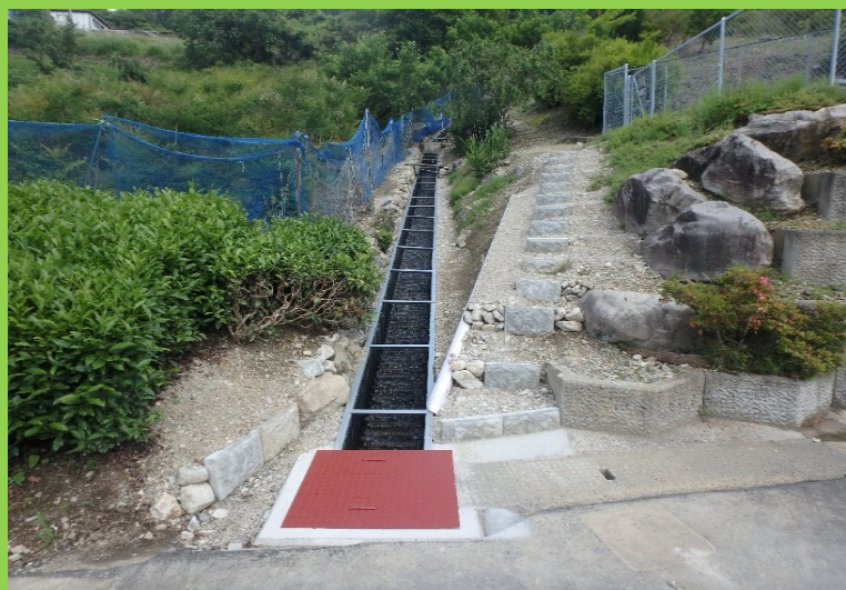
此田地区 水路修繕
