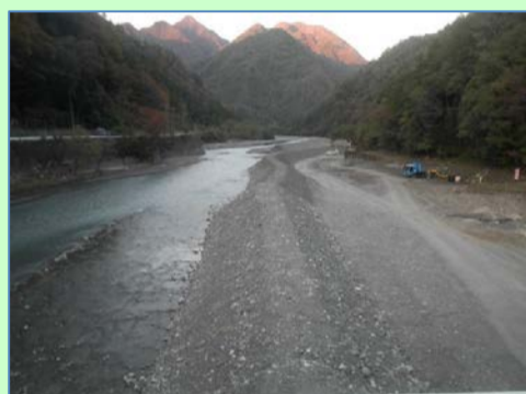
盛土による作業場所の確保
