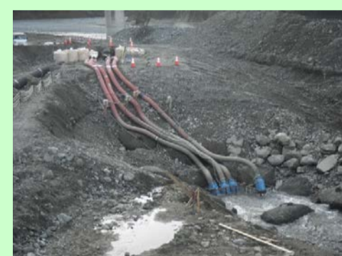
排水の為に水中ポンプがフル稼働
