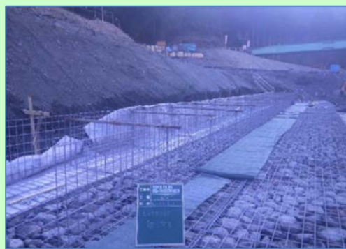
大型かご枠 組立完了
