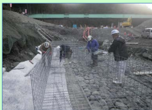
大型かご枠組立状況
