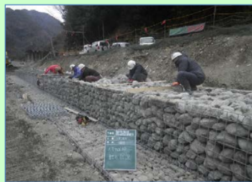
手作業による詰石作業
