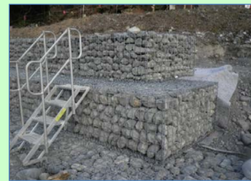
完成した大型かご枠
