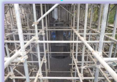
削孔径はビットφ450mmにて削孔します。
