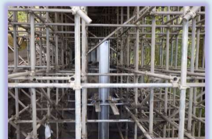
H鋼杭(250)の建込完了です。
