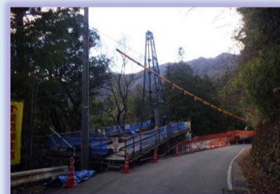
高さ10mのロータリーテーブルマシンで削孔・建込を行います。
