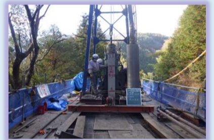
削孔が完了したらH鋼杭(250)を建込みます。
