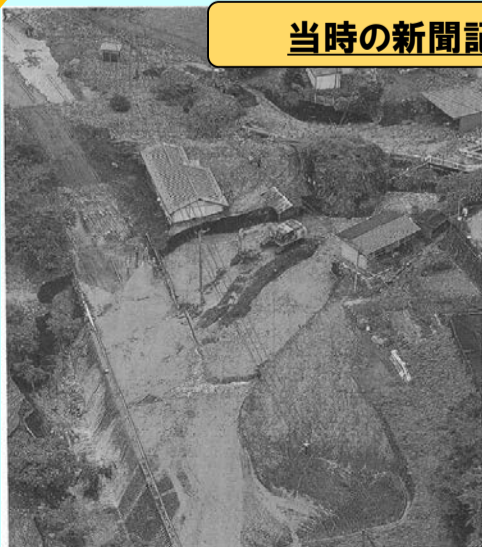
大雨による土砂崩れで寸断された国道152号=15日午後3時48分、飯田市上村中郷
