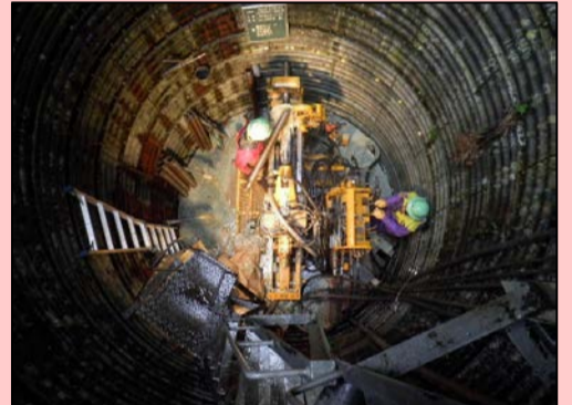
追加施工した集水ボーリング 1本45mの長さです！
