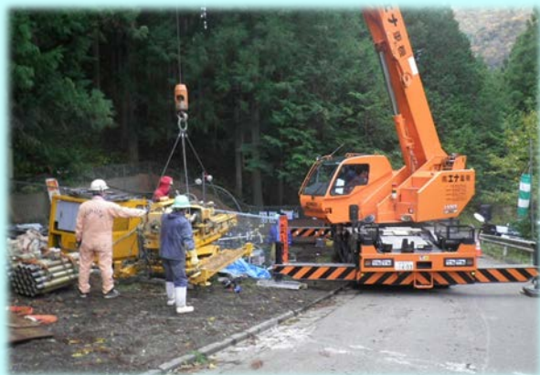
ボーリングマシンや資機材の設置
