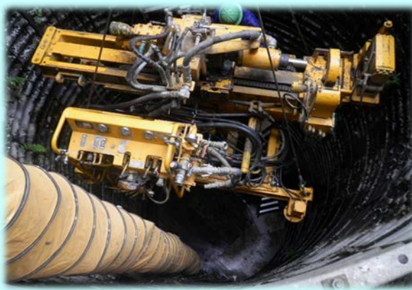
集水井内へのボーリングマシン吊り込み
