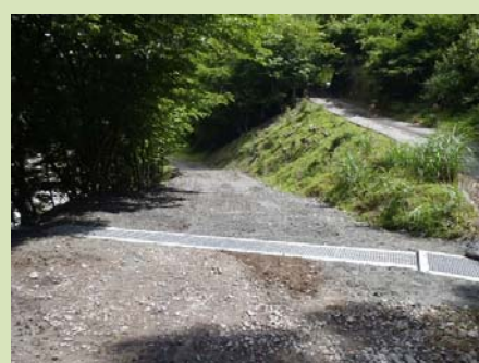
【小嵐 横断水路敷設】
