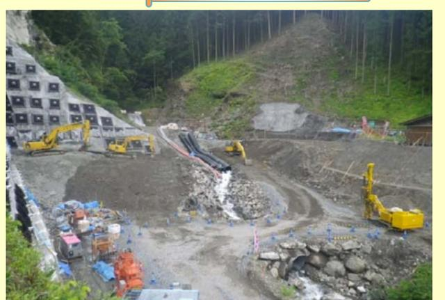
田島建設㈱です。お世話になっております。当現場は仮締切等の仮設工を完了させ堰堤コンクリート打設に向けた掘削作業を継続しております。掘削と並行して残土運搬や法面を安定させる工事も行っています。現場内の重機による災害や法面の崩壊、降雨による土石流に注意するほか、ダンプトラックによる交通事故防止にも気を配りながら安全第一で施工しております。引き続き本工事に関してのご理解ご協力をお願いします。
