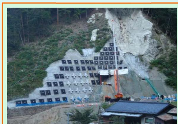
平成27年の5月に掘削法面のアンカー工事を着手してから61本のアンカー工事が完了しました。アンカーの総数は113本でようやく半数が完了したことになります。法面は湧水が多く、硬い岩や軟らかい堆積土等様々で日々変化する現場条件の中、安全第一で工事を進めています。今後も引き続き法面安定のためアンカー工事を施工していきます。また、10月下旬から法面の切土に伴う残土処理を大型ダンプトラックにより、土捨場に搬出します。道路を利用される方にはご迷惑をお掛けしますが、ご理解・ご協力をお願いします。
