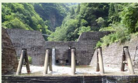
流木除去整備完了
