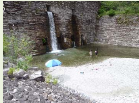
親水護岸利用状況
