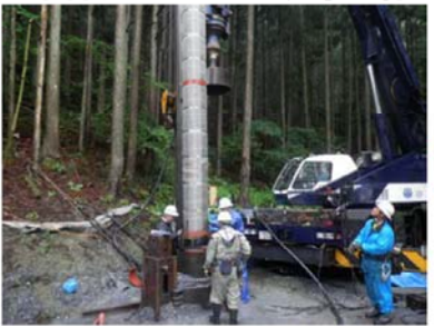
スクリーン管建て込み状況
