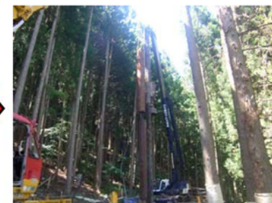
ケーシング継足し状況
