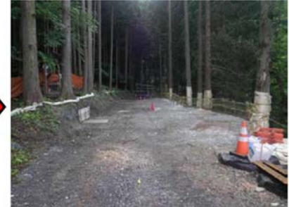
仮設工施工完了
