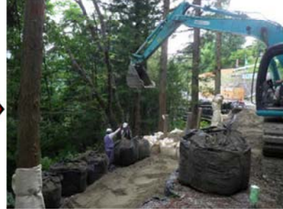
大型土のう設置
