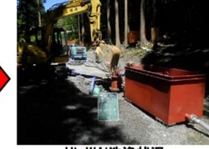
Hi-WAI洗浄状況
