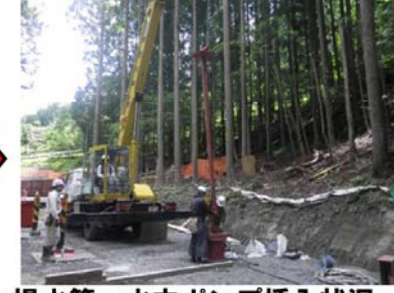
揚水管・水中ポンプ挿入状況
