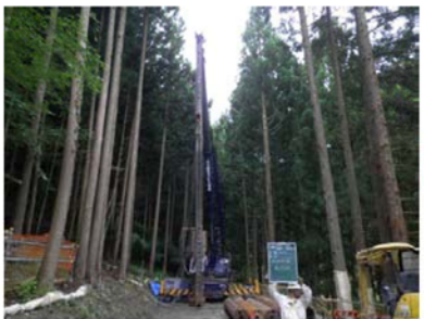
掘削機械組立完了
