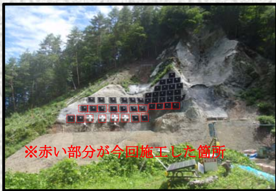
アンカー工事の様子
