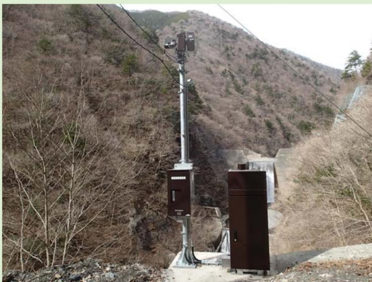
本件は、天竜川上流河川事務所管内にカメラによる土石流監視整備の一貫として、各砂防出張所管内(小波川3台、飯島4台、遠山川2台)に9台の設置と光・電源ケーブルの布設を行いました。写真は北又渡の全影写真ですが、ここは無線LANによる回線構成を行いました。施工期間中は地域の皆様のご理解をいただき、無事故・無災害にて完了することができました。
