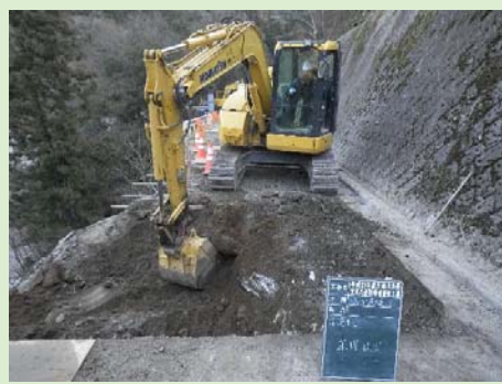
② 地盤の掘削状況
