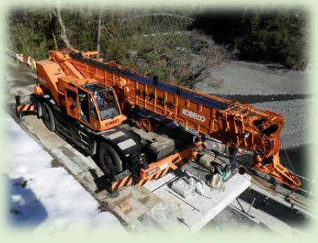
⑤ 50 t ラフレッタクレーンの設置状況
