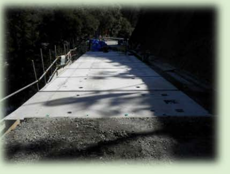
⑧ 8 枚のスラブ据付完了
