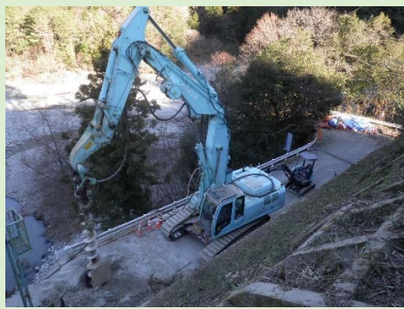
① 鋼管杭の削孔・設置
