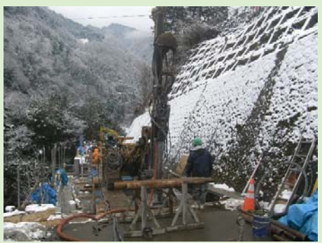
④ グラウンドアンカーの削孔・挿入
