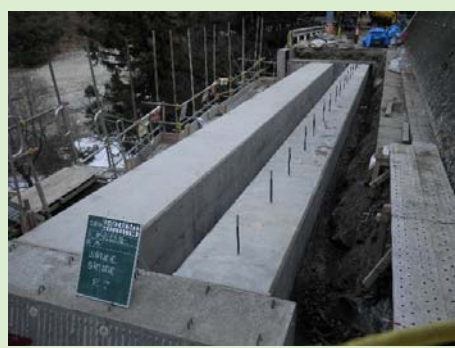
③ 枕梁の完成
