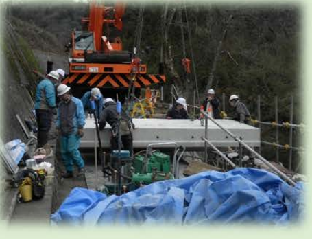
⑦ スラブの据付作業状況
