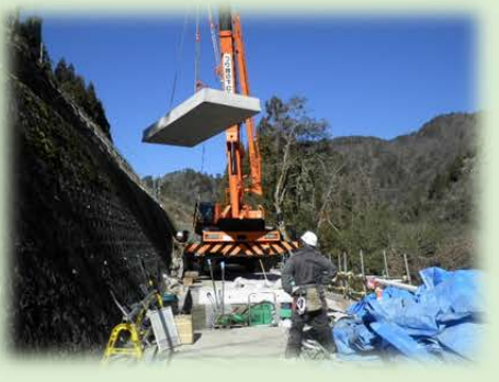
⑥ 8.4 t のスラブを吊り上げ
