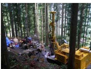
観測用ボーリング状況
