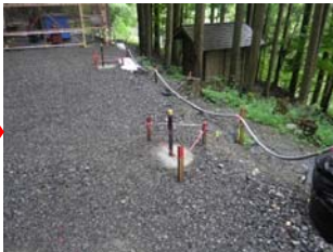
観測用ボーリング完了
