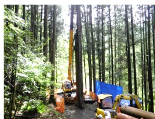
掘削状況（ダウンザーホールハンマー）
