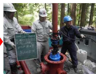
ポンプ・揚水管設置状況
