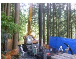
スクリーン管建込状況
