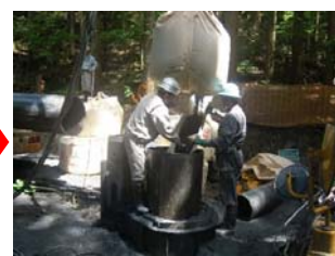
フィルター材（砂利）充填状況
